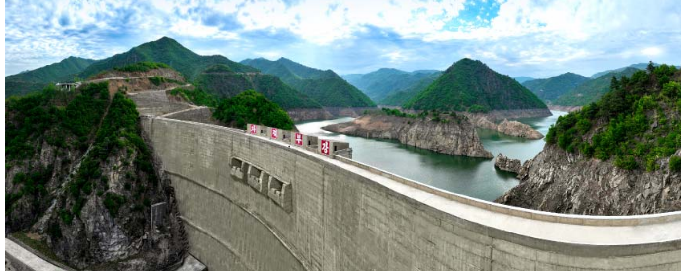
Успешное завершение строительства Танчхонской ГЭС (1-я очередь).
