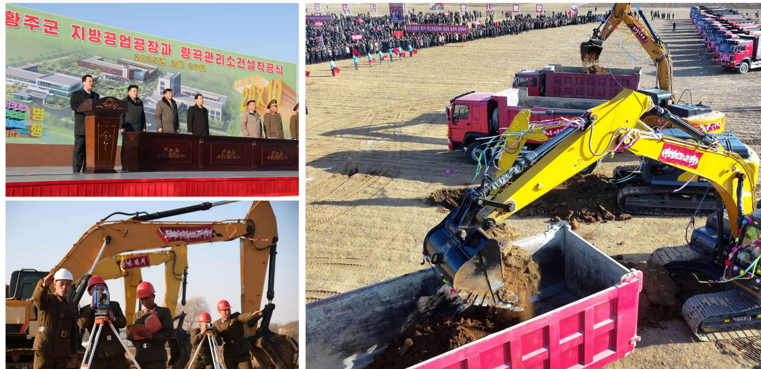
Закладка предприятий и зернохранилища в уезде Хванчжу
