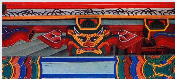
Балка павильона Ыльмир.
