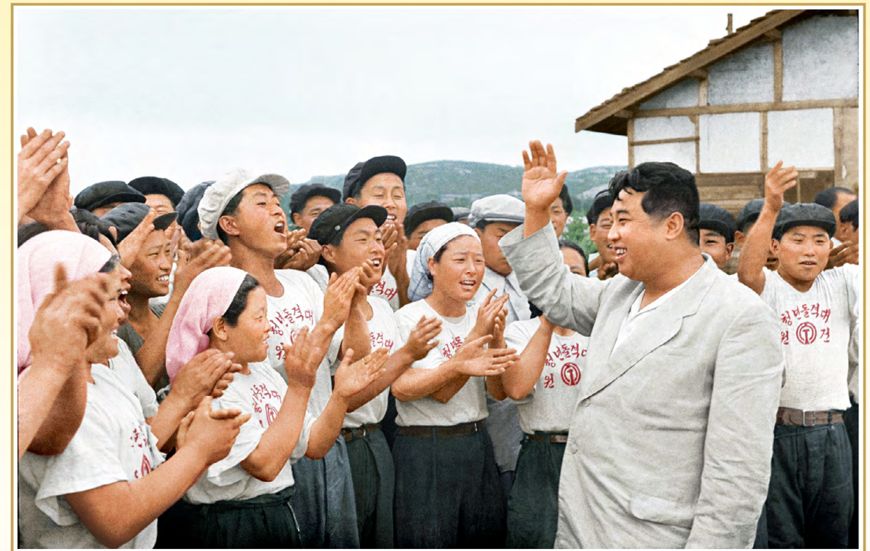
На стройке для прокладки железнодорожной линии Хэчжу – Хасон Ким Ир Сен вдохновляет молодых строителей. Июнь 47 года чучхе (1958).
