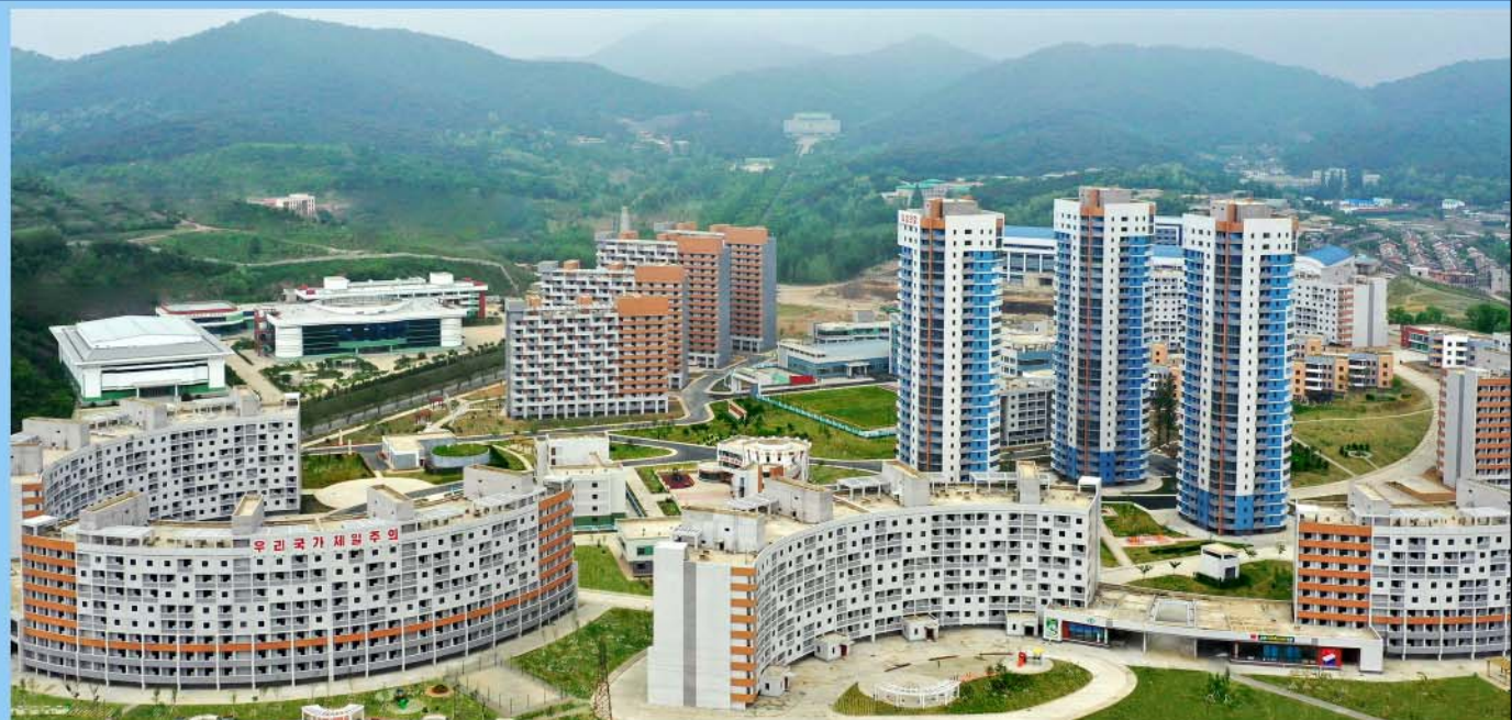
Завершено строительство жилых домов в районе Тэпхёна (май 2023 г.).
