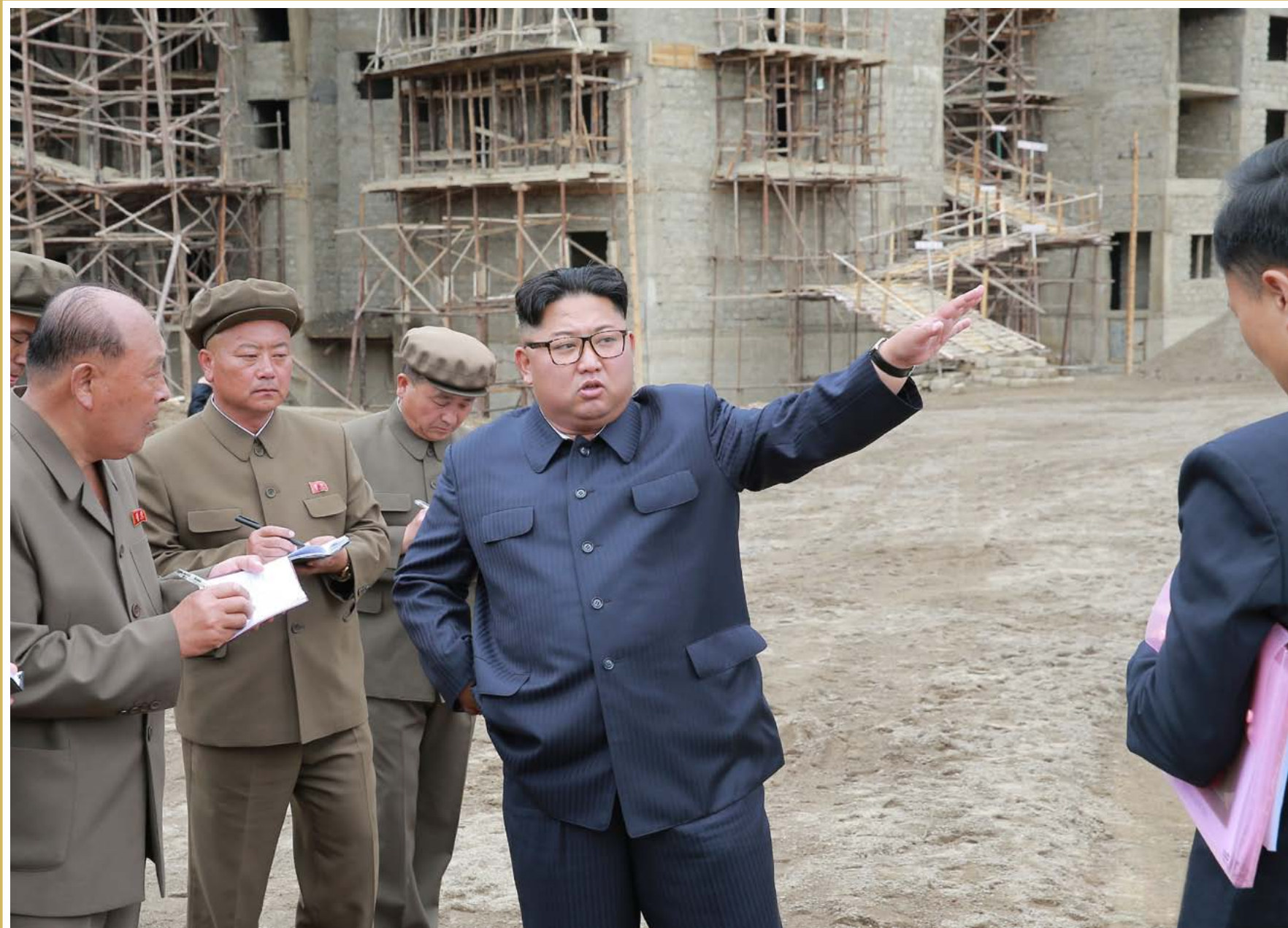
На стройке в уезде Самчжиён. Июль 2018 г.
