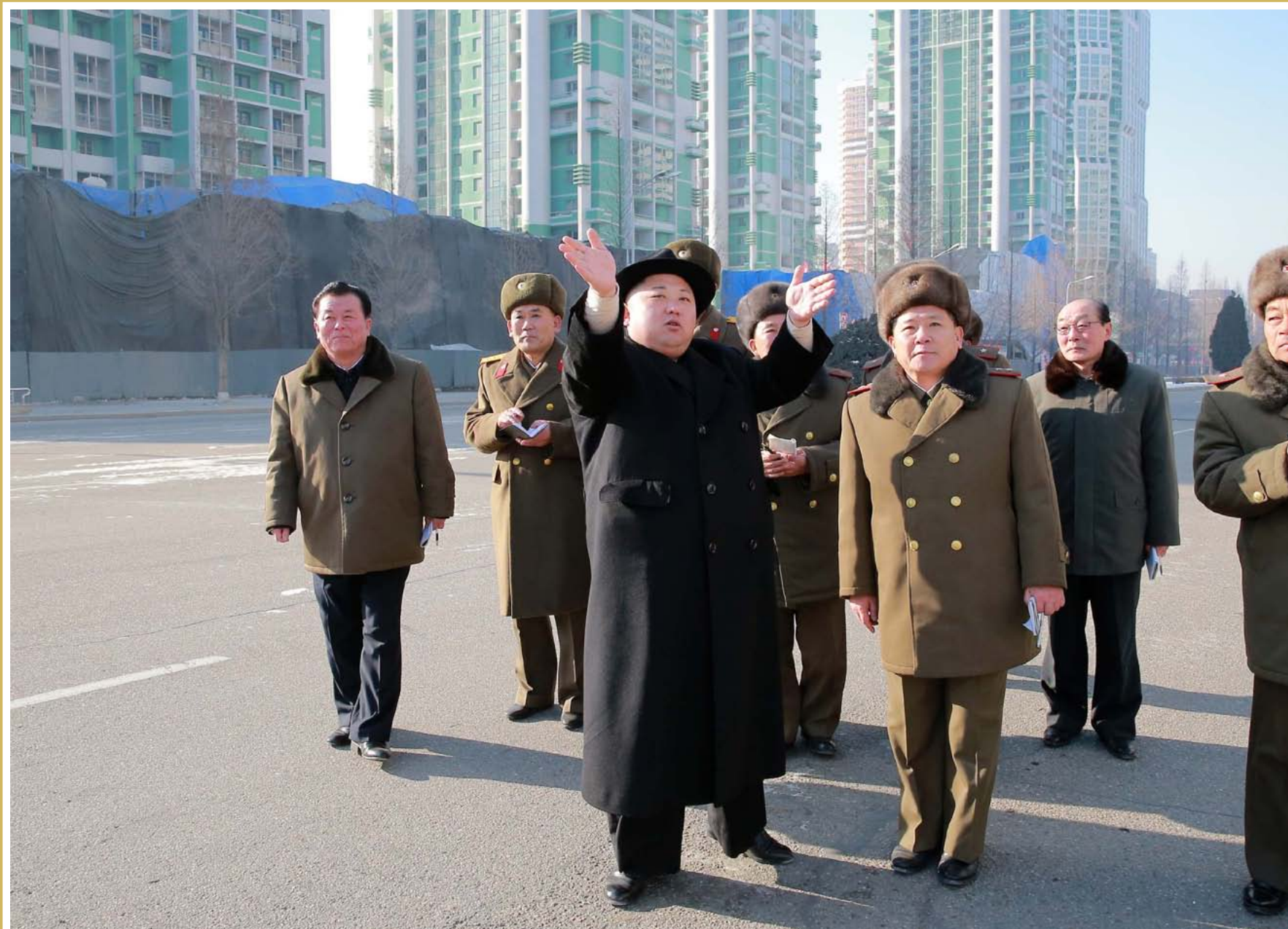
На стройке улицы Рёмён. Январь 2017 г.
