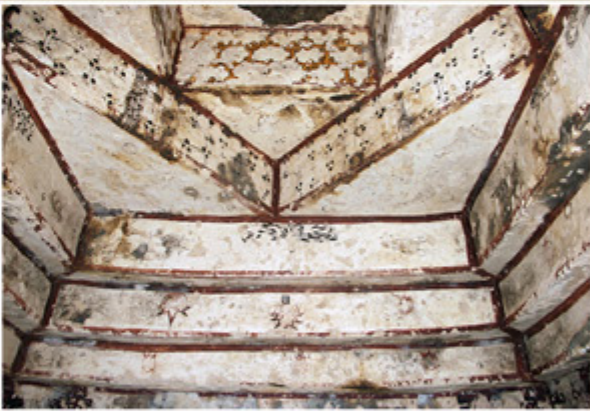
Сводчатый потолок с трехступенчатыми карнизами.
