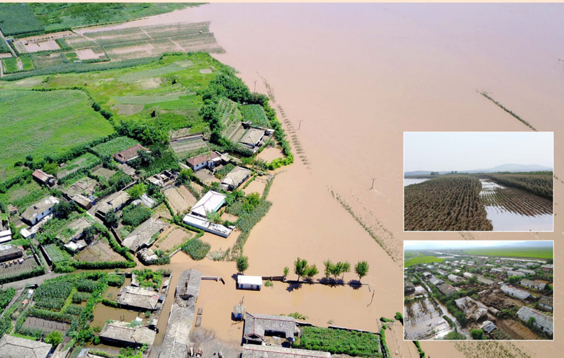
Часть села Тэчхон уезда Ынпха провинции Северный Хванхэ, понесшего ущерб от наводнения.
