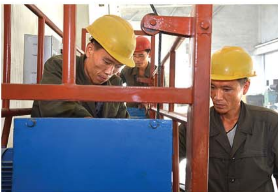
Сборка моторных само- подъемных лесов.
